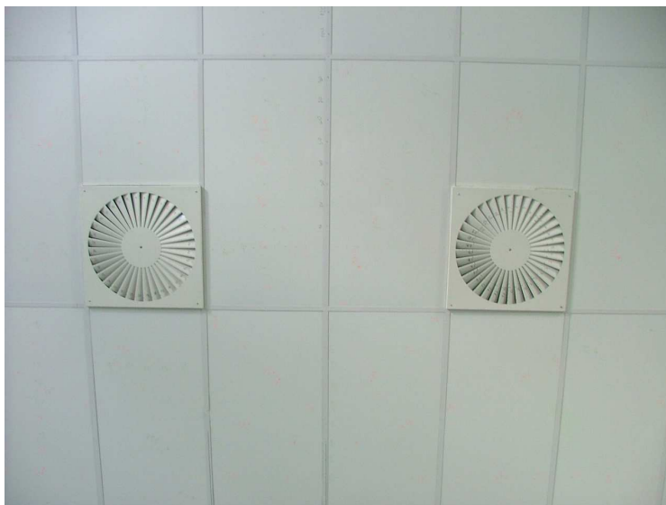
Slika 5.21 Instalacija difuzora za proizvodnju spojenog mlaza na udaljenosti b_{\text{dif}} = 180 cm
