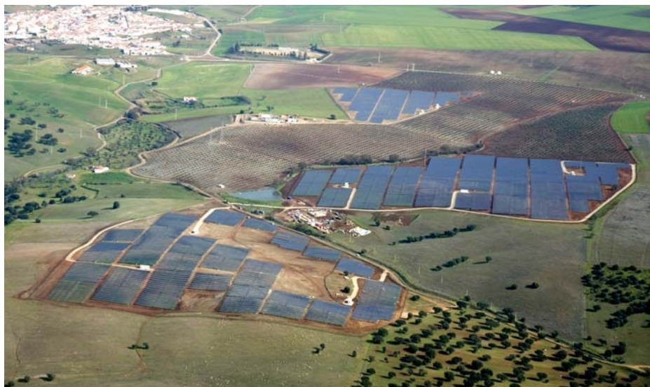
Slika 1. Panoramski pogled na 11 MW solarnu elektranu u okolici Serpe, Portugal
