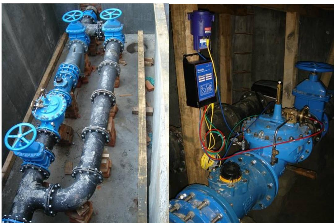
Slika 4.5. Mjerno-regulacijska komora za kontrolu protoka regulacijom tlaka na ulazu u DMA
