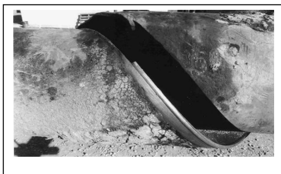
Slika 2.23 Pucanje spiralno zavarene cijevi uslijed djelovanja SOHICa (Shell Canada) [20]
