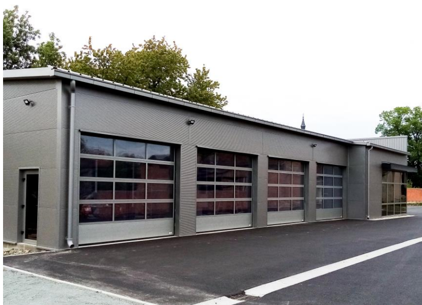
Slika 1.12. Hala korištena u radu – pogled sa zadnje strane
