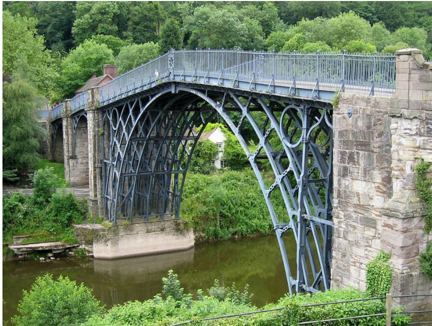
Slika 1.5. Prva nosiva konstrukcija od željeza u svijetu [5]
