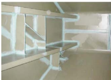
Slika 2.5 - Naneseni zaštitni premaz (epoksi tip) u tankovima balasta naftnog tankera [31]
