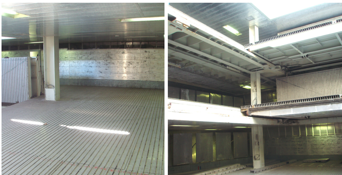
Sl. 2.3. Unutrašnjost broskog rashladnog skladišta
