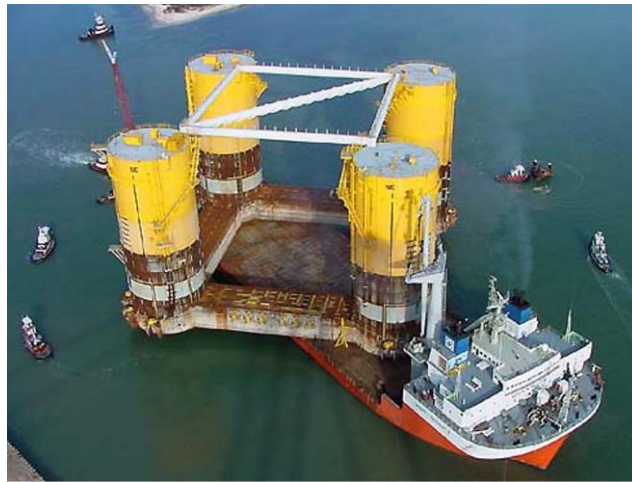
Slika 1.4 - Brutus TLP, podvodni dio (Izvor: http://www.offshore-technology.com/projects/brutus/brutus6.html )
