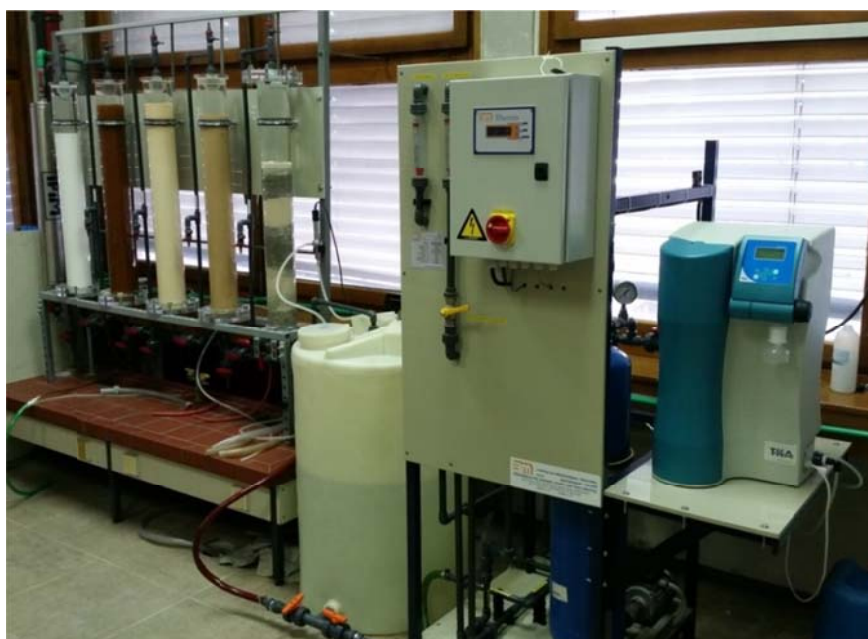
Slika 25. Sustav za proizvodnju deionizirane vode u Laboratoriju za vodu, gorivo i mazivo FSB-a.
