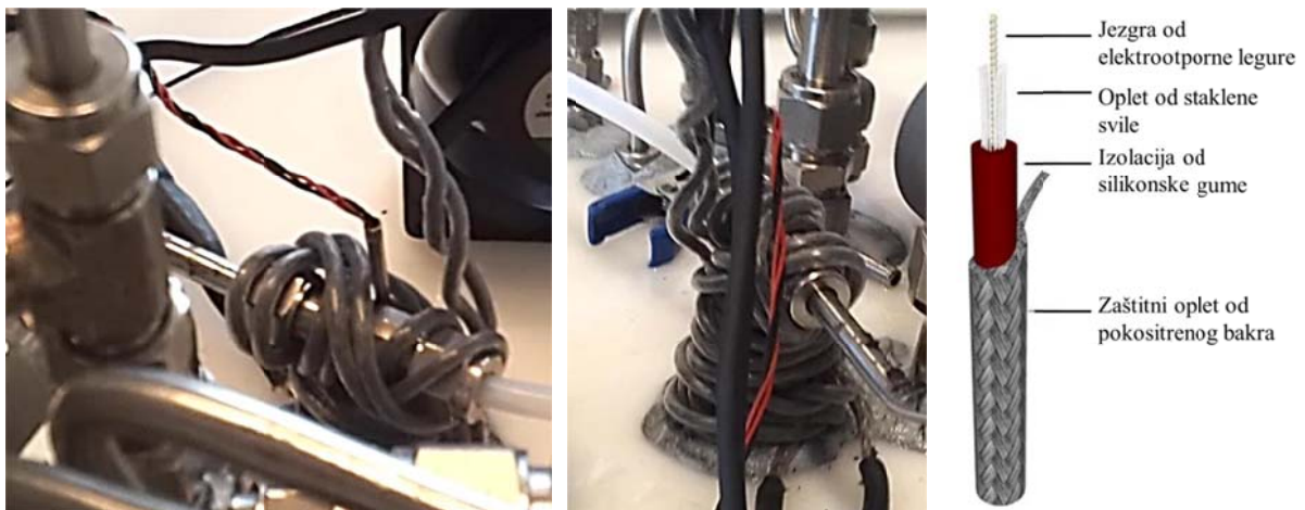
Slika 12. Grijajući kabel na izlaznoj cijevi LRS-a, ilustracija desno iz [43].
