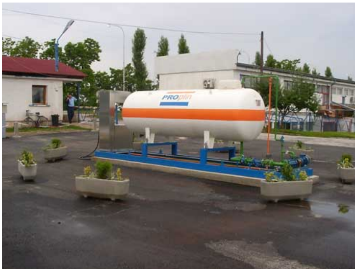
Slika 2.3. UNP u cilindričnom spremniku [4]
