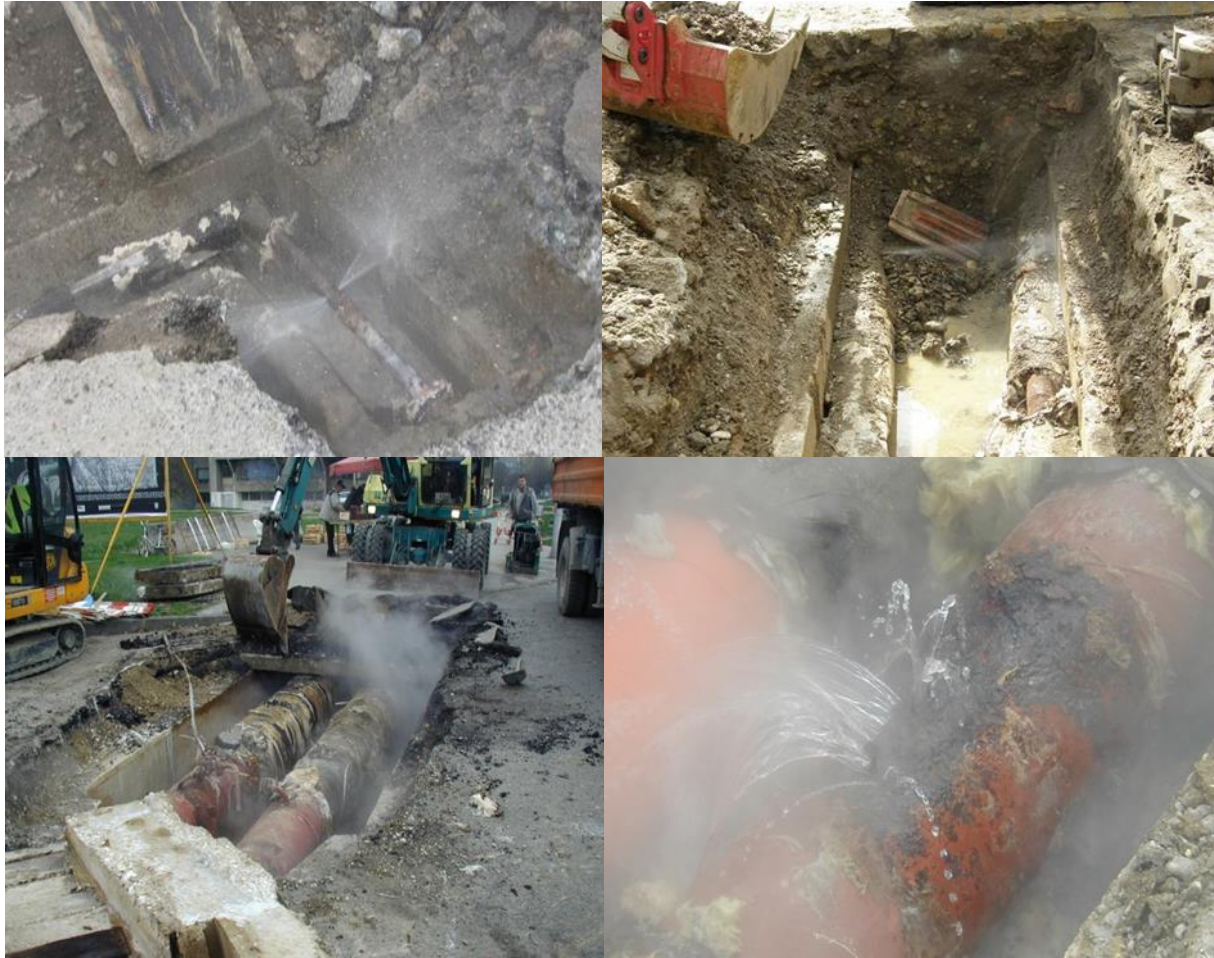
Slika 7.13. Propuštanja cjevovoda
