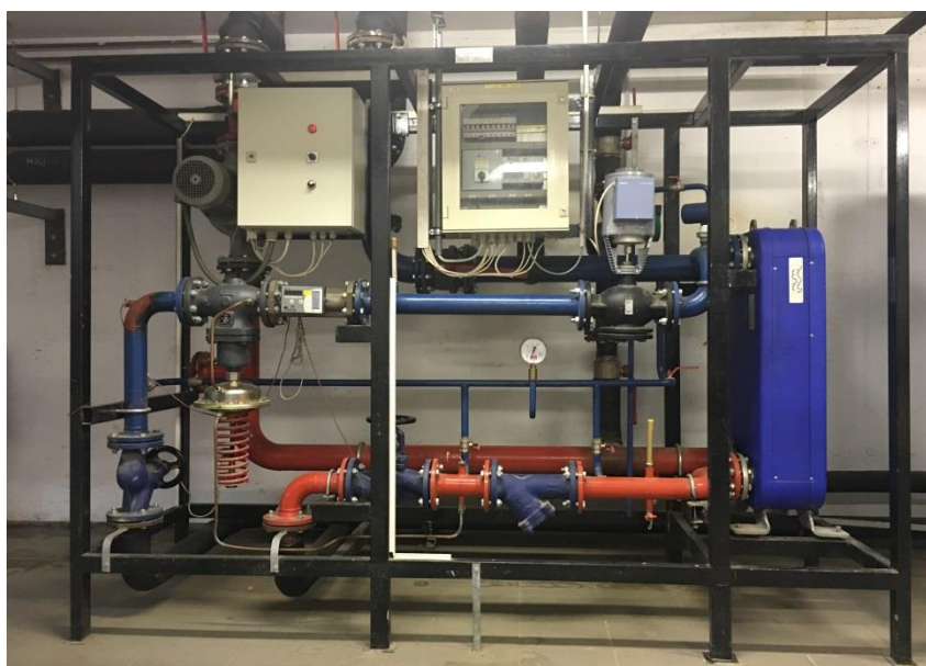
Slika 10.5. Toplinska podstanica indirektnog tipa (Kompakt)
