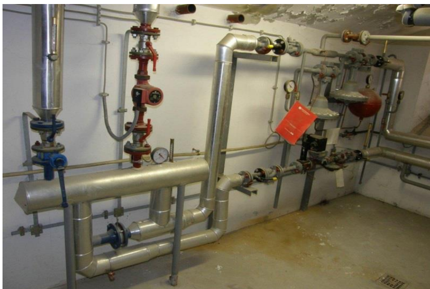
Slika 10.4. Toplinska podstanica direktnog tipa
