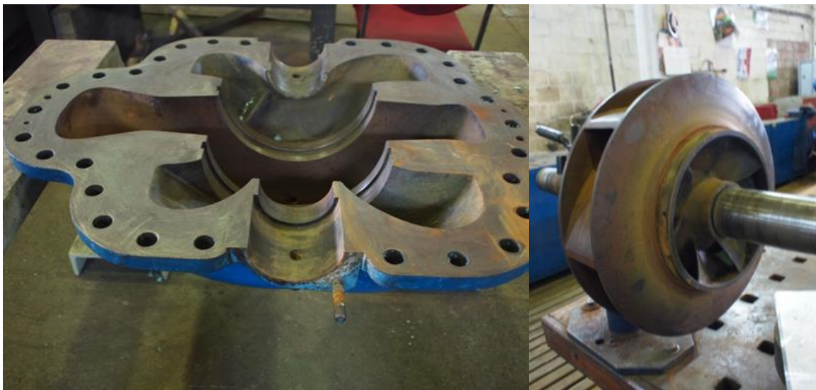
Slika 5.5. Remont booster crpke
