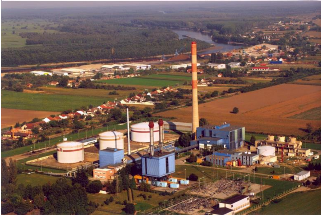
Slika 10.2. Termoelektrana - toplana Osijek
