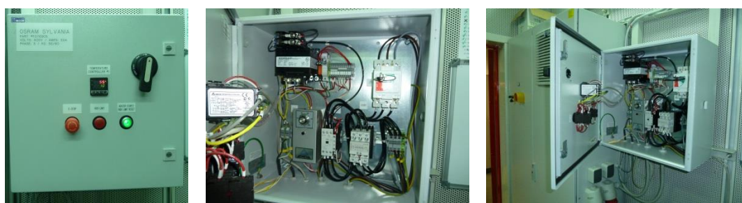
Slika 2.25. Upravljanje radom grijača zraka
