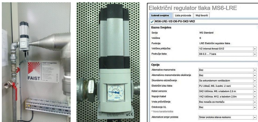
Slika 2.19. Regulator tlaka FESTO
