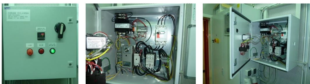
Slika 2.25. Upravljanje radom grijača zraka
