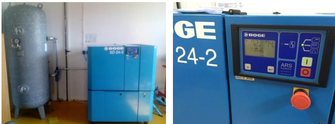
Slika 2.18. Kompresor BOGE SD24-2 (lijevo) i spremnik zraka 1000 l (desno)
