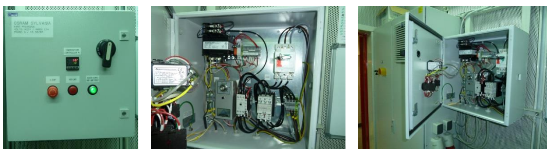
Slika 2.25. Upravljanje radom grijača zraka
