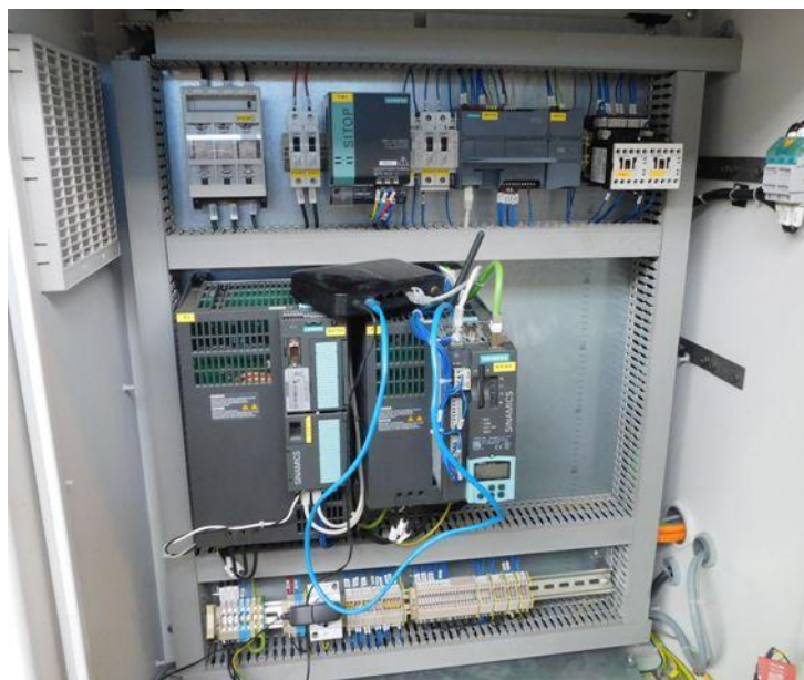
Slika 4.7 Upravljački dio stroja za mikrobušenje
