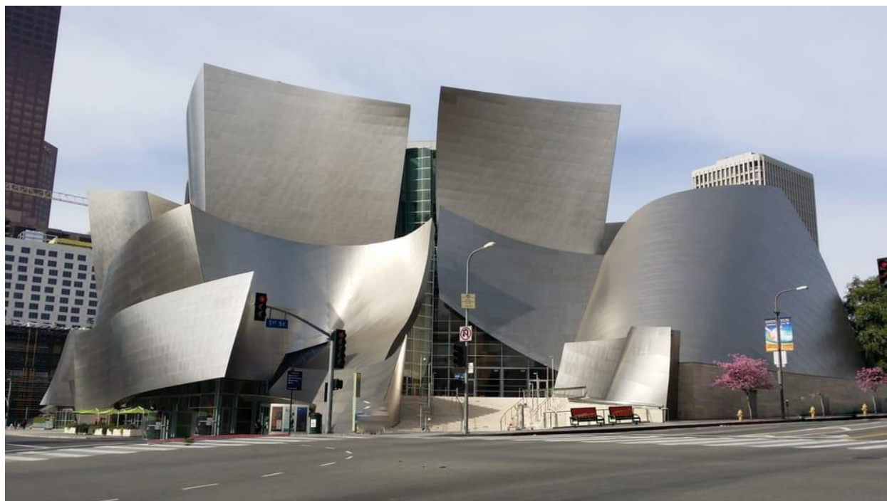
Slika 41. Građevina kompleksne geometrije izrađena pomoću virtualnih tehnologija
