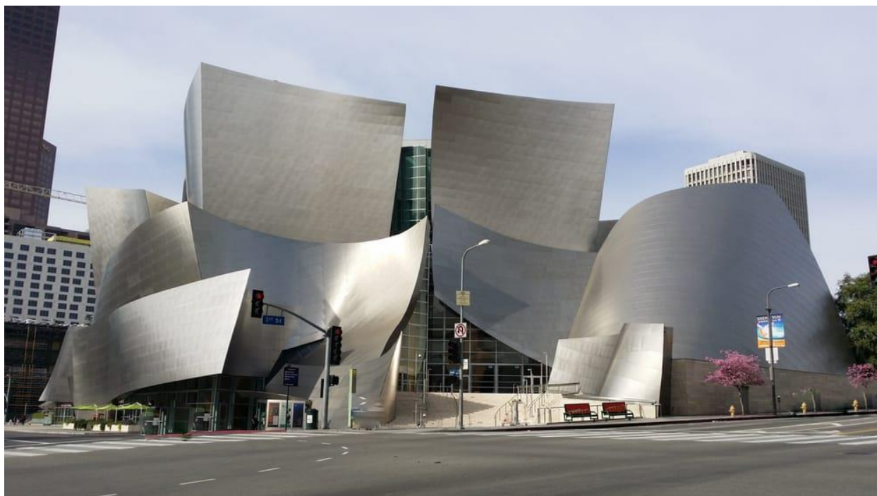
Slika 41. Građevina kompleksne geometrije izrađena pomoću virtualnih tehnologija
