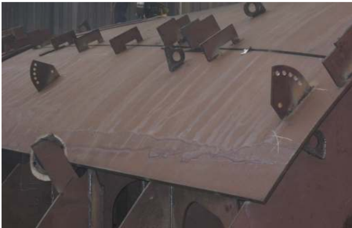
Slika 33. Postavljanje limova vanjske oplata
