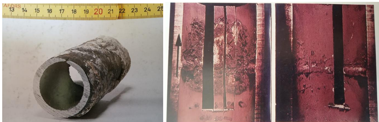
Slika 2. Primjeri kemijske korozije [4]
