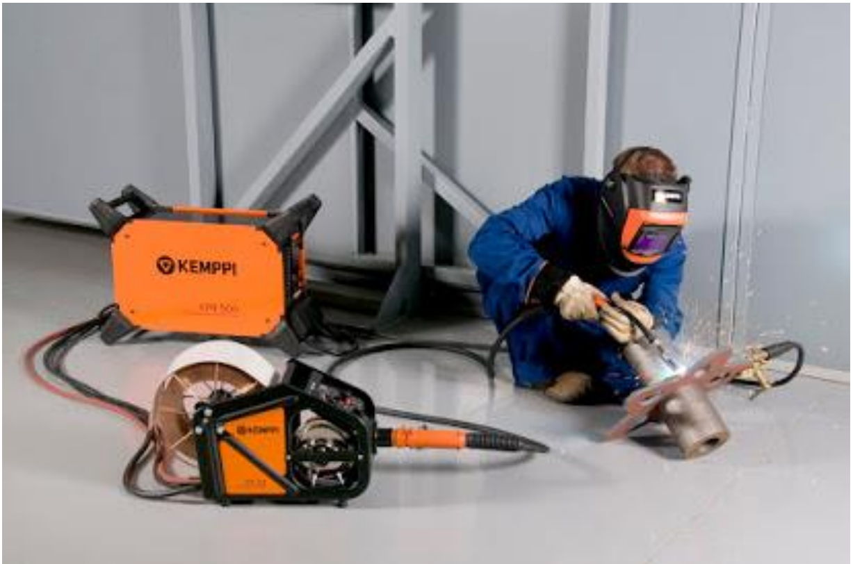
Slika 2. PoluautomatskoMIG/ MAG zavarivanje [10]
