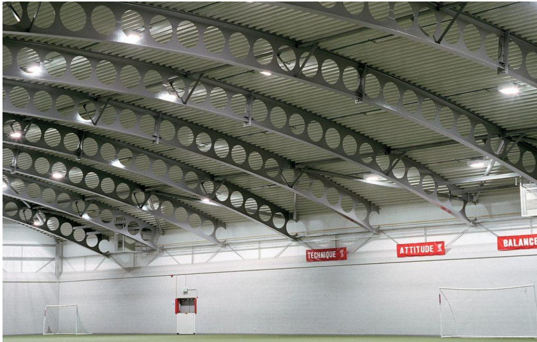
Slika 3. Krovni I - profili s otvorima [4]
