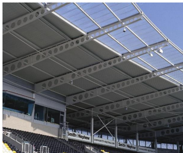
Slika 4. Estetska funkcija prošupljenih I – profila [5]
