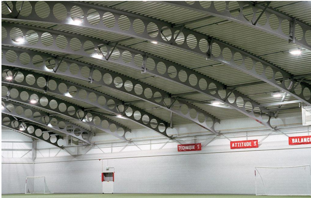
Slika 3. Krovni I - profili s otvorima [4]
