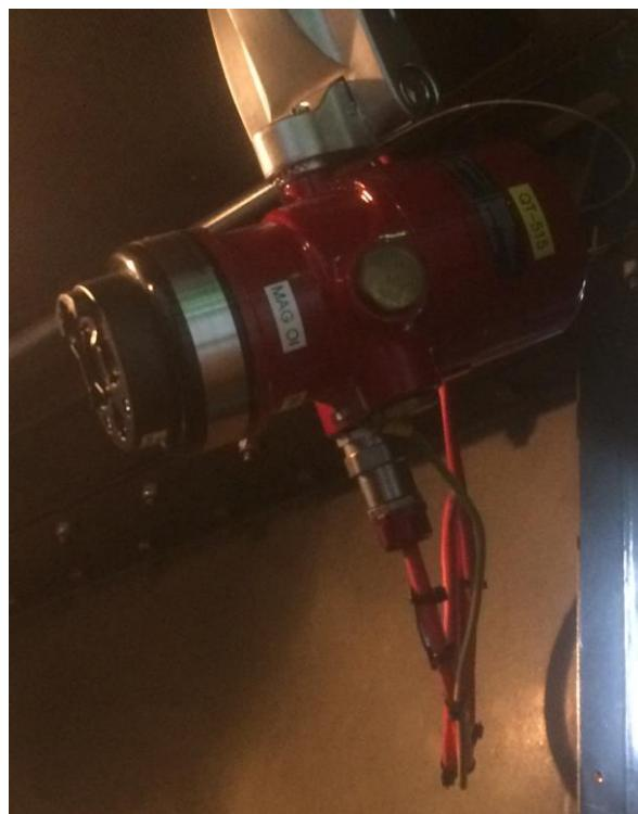
**Slika 26. Kamera za detekciju požara**
