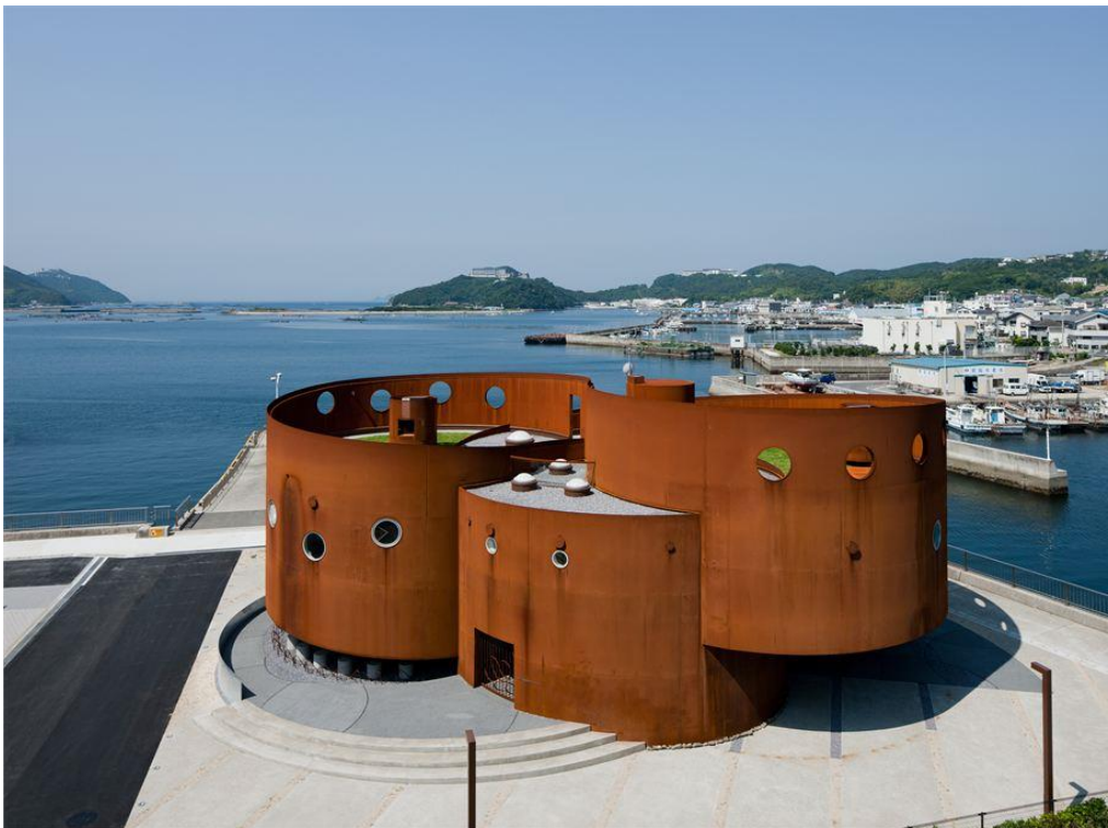
Slika 5. Corten čelik u blizini mora – The Fuktura Port in Japan [16]
