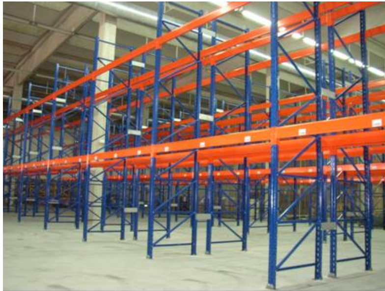
Slika 27. Paletna regalna konstrukcija
