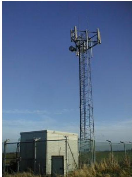
Slika 1. Primjer bazne stanice
