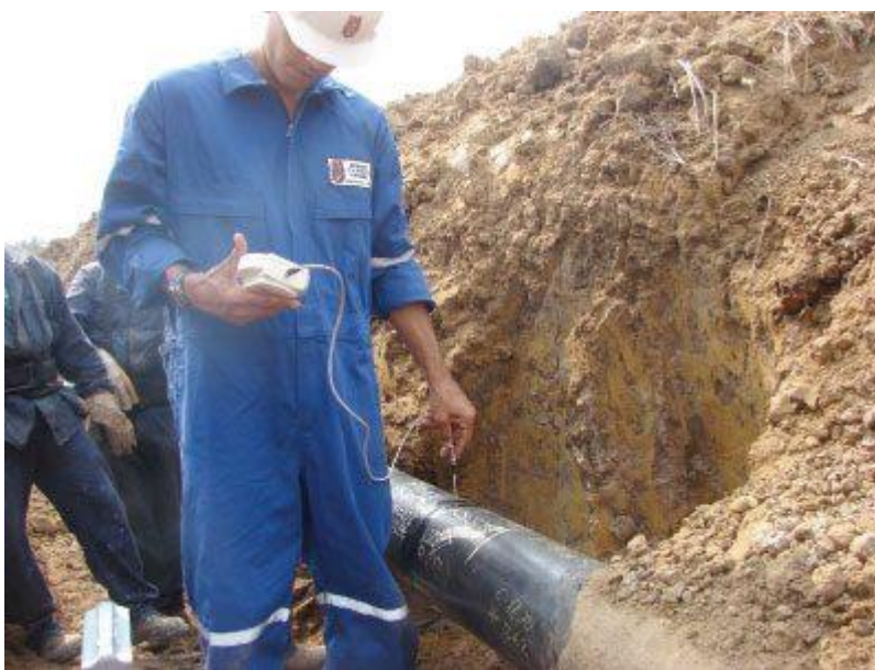
Slika 12. Mjerenje zaostalog magnetizma prije zavarivanja cjevovoda na terenu [10]
