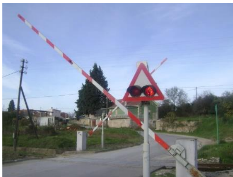
Slika 2 Prijelaz zaštićen branicama i svjetlosnim signalima [2]
