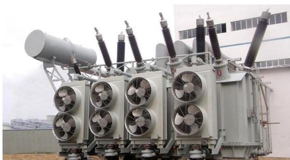
**Slika 19. Rashladni sustav transformatora - hladnjak s ventilatorima [21]**
