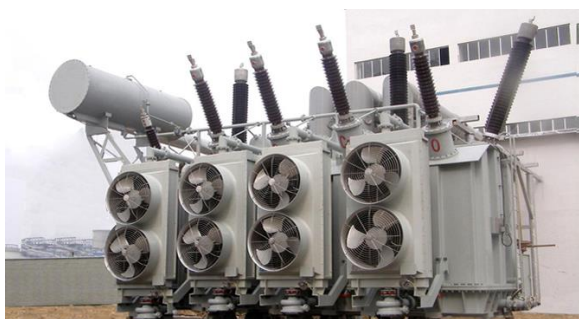
Slika 19. Rashladni sustav transformatora - hladnjak s ventilatorima [21]
