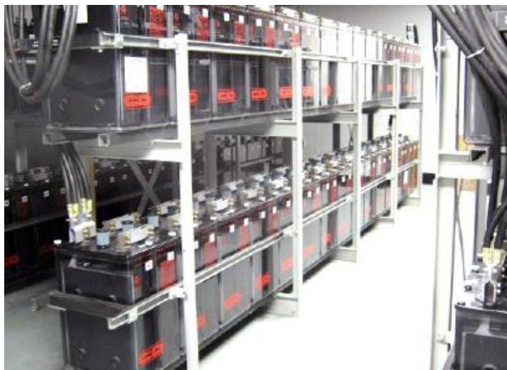
Slika 8. Baterijski UPS-ovi [4]
