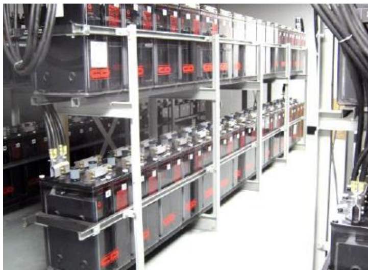
Slika 8. Baterijski UPS-ovi [4]
