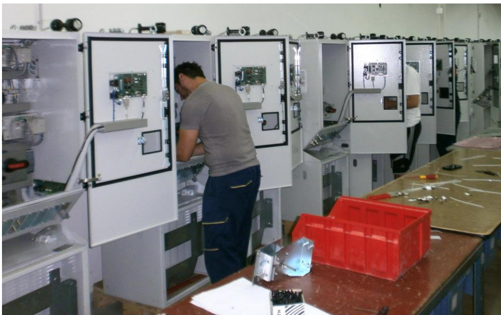
Slika 36. Montaža konačnog proizvoda [22]
