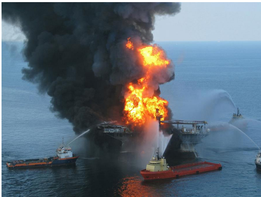
Slika 5. Naftna platforma Deepwater Horizon nakon eksplozije
