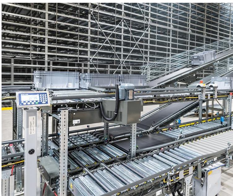
Slika 1. Primjer dijela transportnog sustava automatiziranog skladišta
