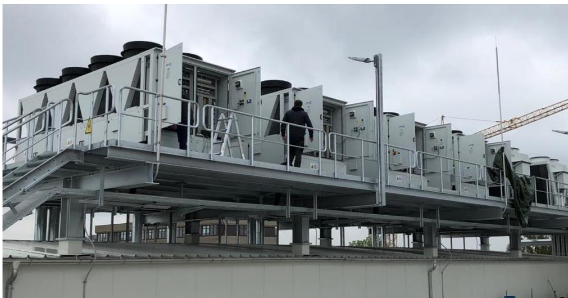
Slika 3 Zrakom hlađen rashladnik kapljevine, Frigo Plus
