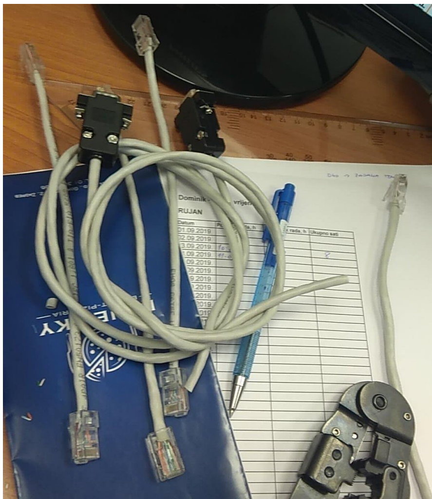
Slika 60. Komunikacijski kabeli za Ethernet i RS422
