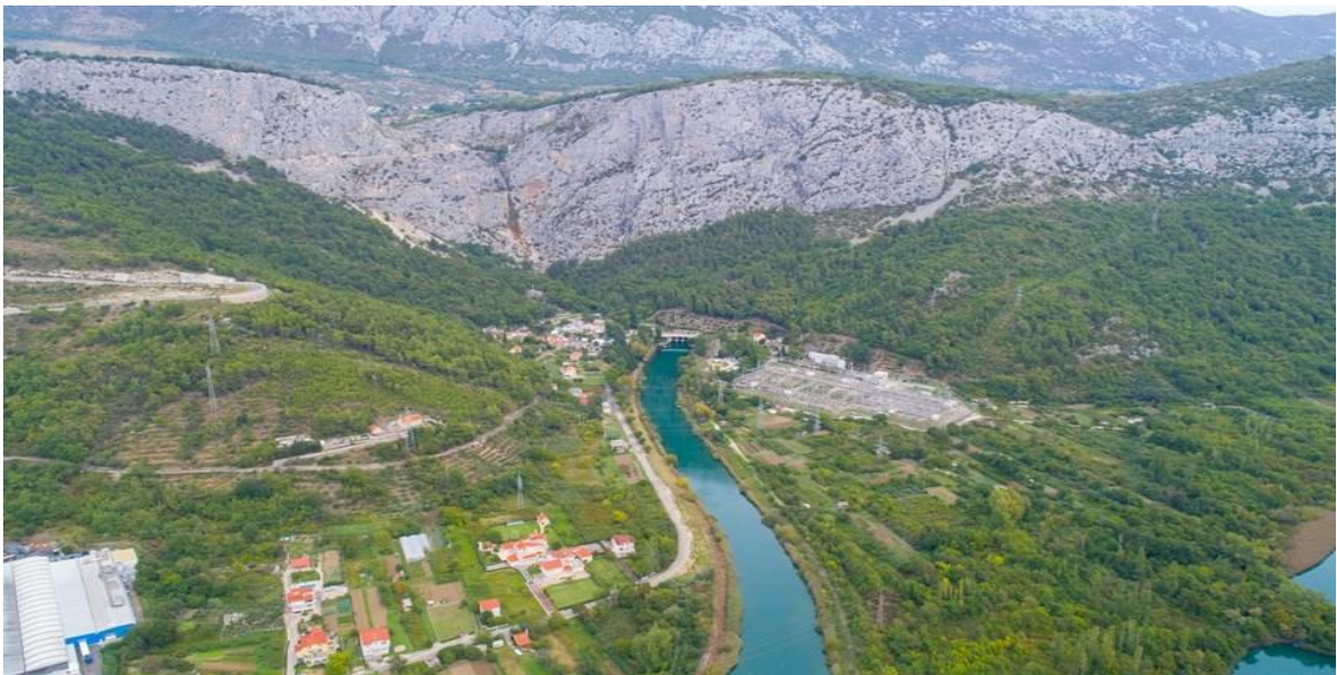
Slika 9. HE Zakučac - izlazna građevina i rasklopište
