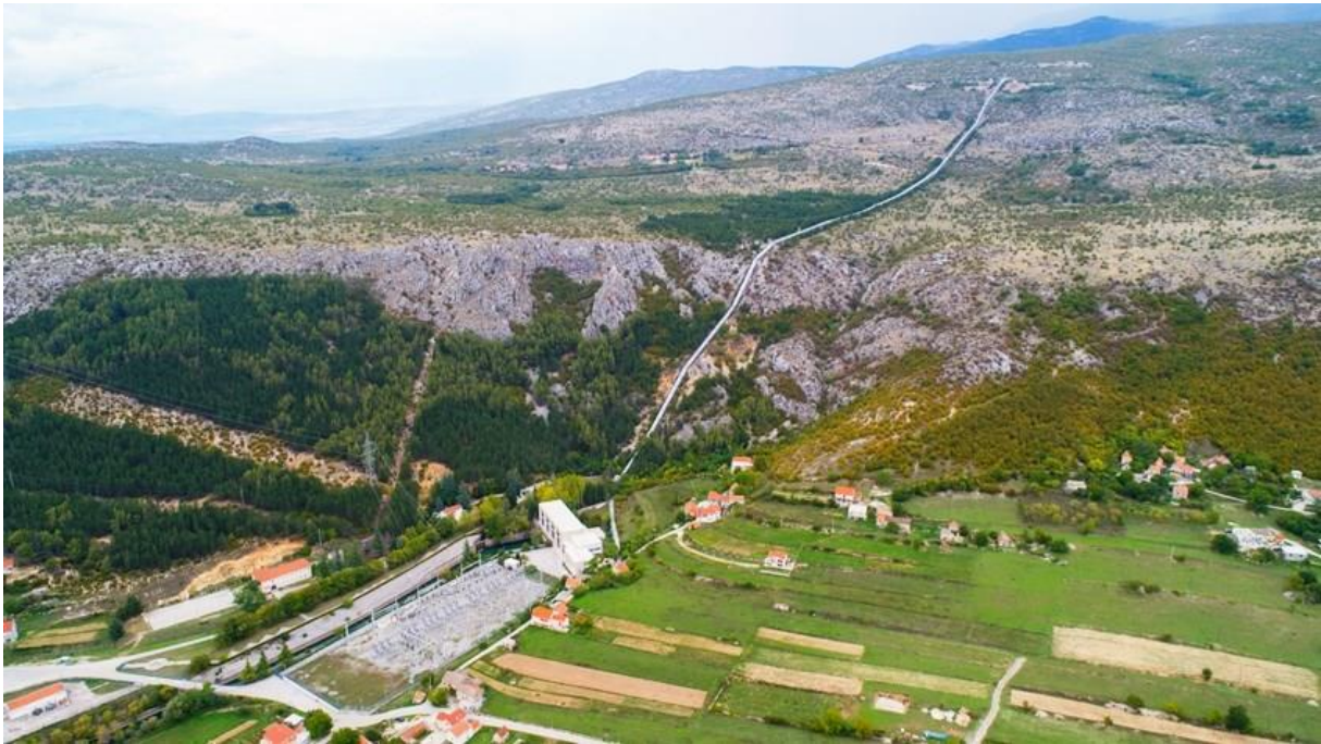
Slika 4. HE Orlovac i dovodni tunel [8]
