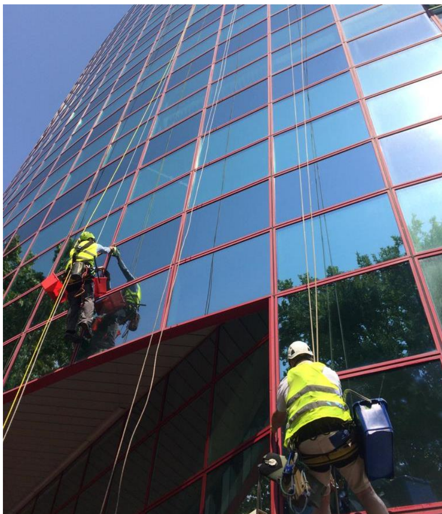
Slika 24. Pranje staklenih fasada
