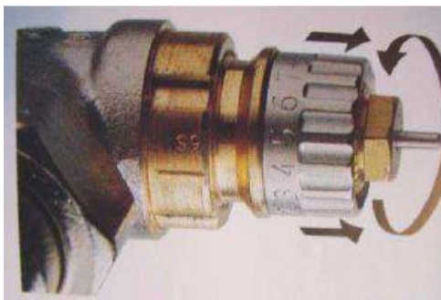
Slika 2.17. Predpodešenje termostatskog ventila
