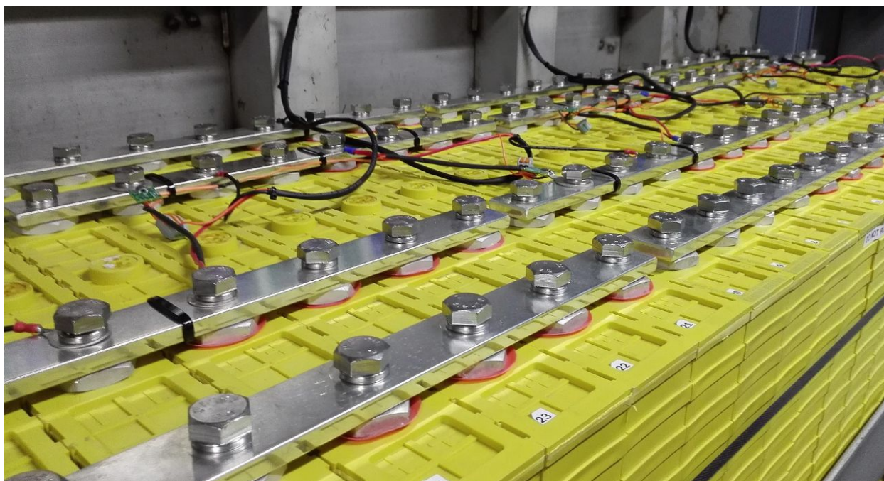
Slika 16. Više ćelija \text{LiFePO}_4 baterije spojeno serijski i paralelno da bi stvorili bateriju od 2800Ah i 52V
