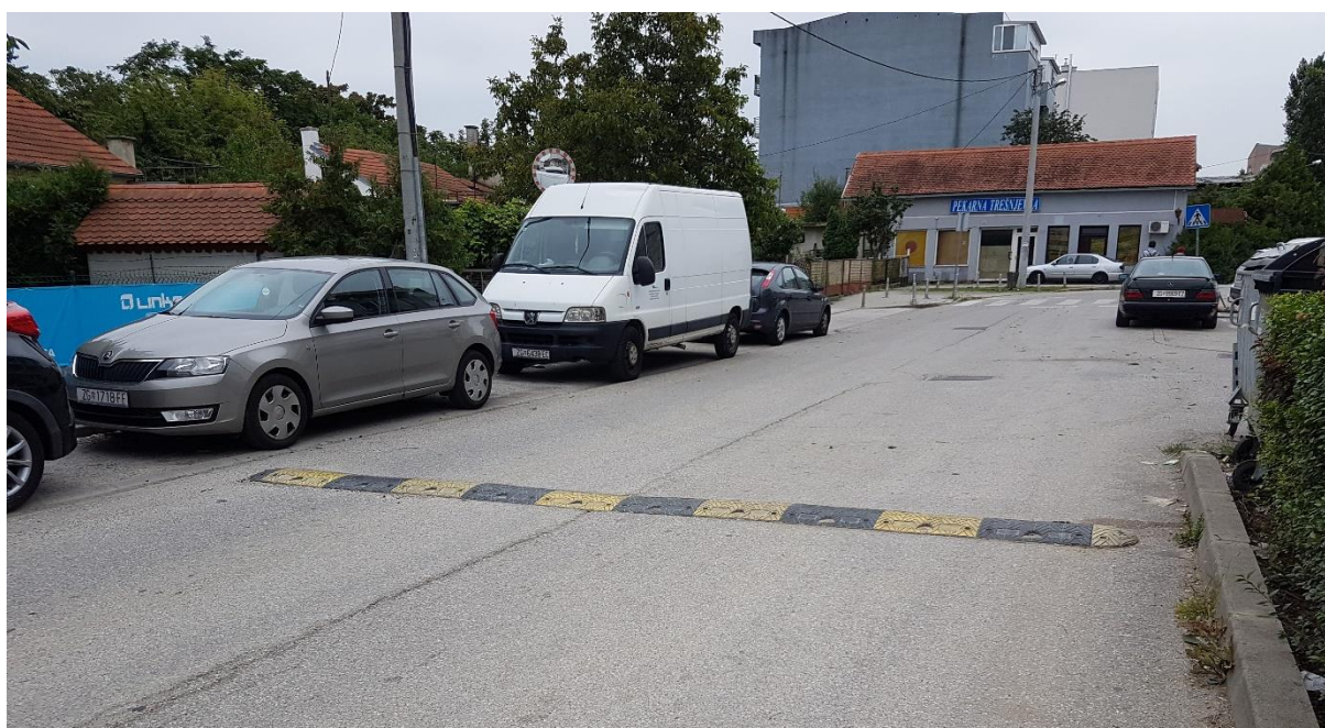
Slika 30. Umjetna izbočina postavljena u Dobojskoj ulici
