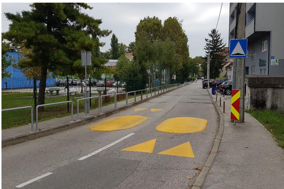
Slika 34. Novopostavljena uzdignuta ploha na Novoj cesti
