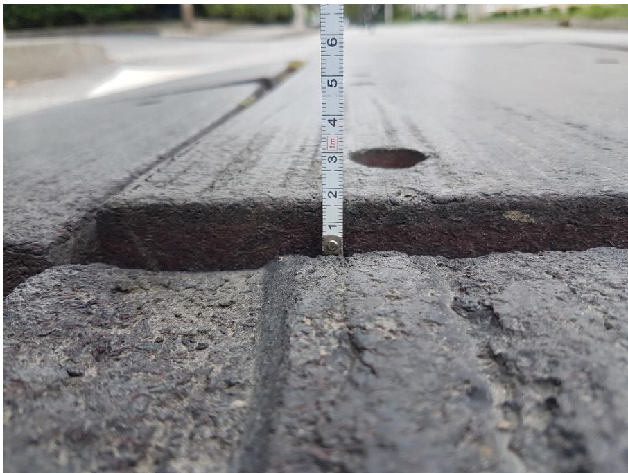
Slika 38. Primjer međusobnog izdizanja gumenih elemenata
