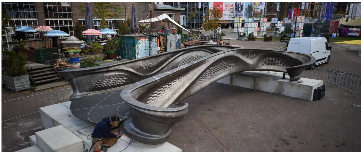
Slika 5. MX3D - most dobiven WAAM tehnologijom [9]
