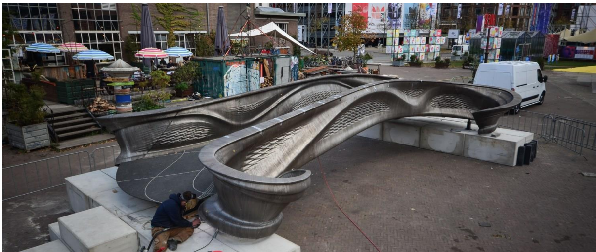
Slika 5. MX3D - most dobiven WAAM tehnologijom [9]
