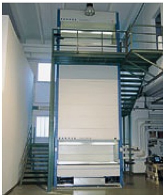
Slika 17. Instalirani VLM s dva otvora [2]
