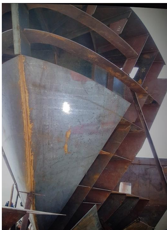
Slika 5. Gradnja čeličnog trupa broda
