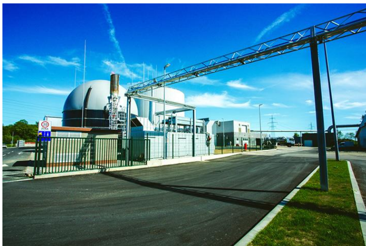
Slika 4.3. Bioplinsko postrojenje (kogeneracijski dio postrojenja)
