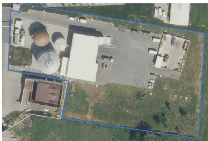
Slika 8.1. Površina predmetnog bioplinskog postrojenja
