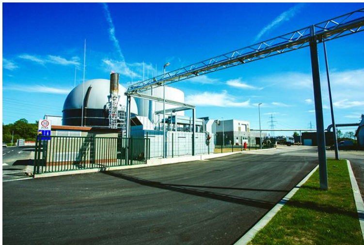
Slika 4.3. Bioplinsko postrojenje (kogeneracijski dio postrojenja)
