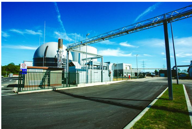
Slika 4.3. Bioplinsko postrojenje (kogeneracijski dio postrojenja)
