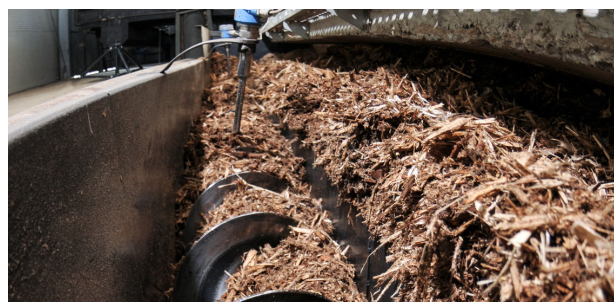
d) prijenos biomase pužnim vijcima
